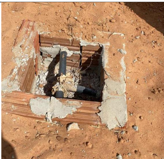
Figura 3. Escavação para colocação de posto de concreto e entorno de alvenaria e passagem de eletroduto
