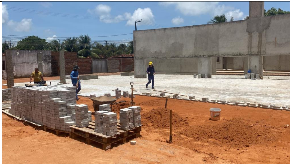
Figura 7. Compactação do solo para instalação do piso intertravado.
