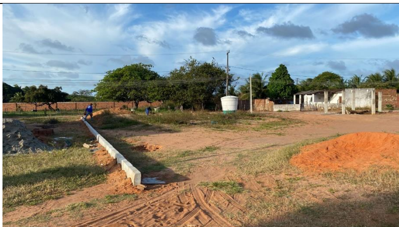
Figura 8. Execução do meio fio da praça de murici
