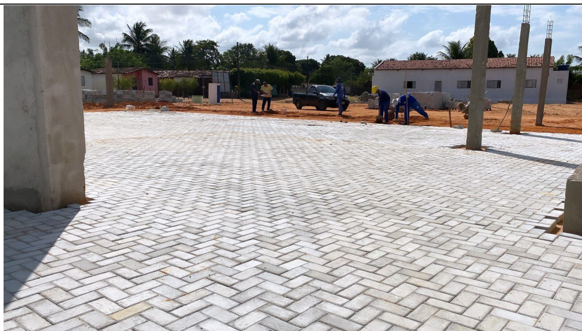
Figura 6. Instalação do piso intertravados de cor natural.
