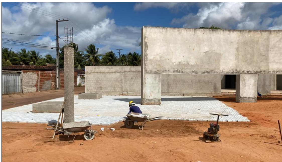
Figura 1. Execução da praça do Murici.
