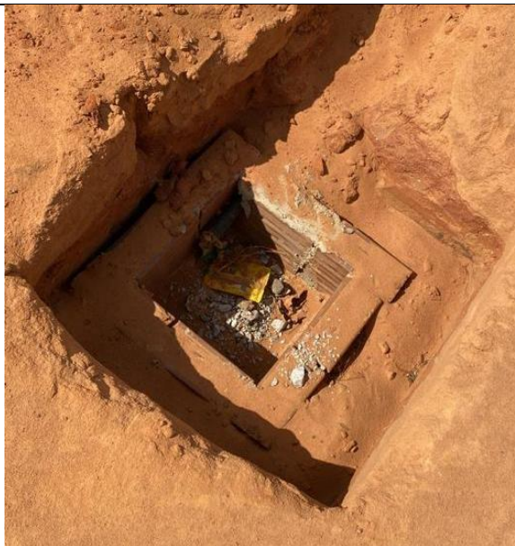
Figura 2. Escavação para colocação de posto de concreto e entorno de alvenaria.
