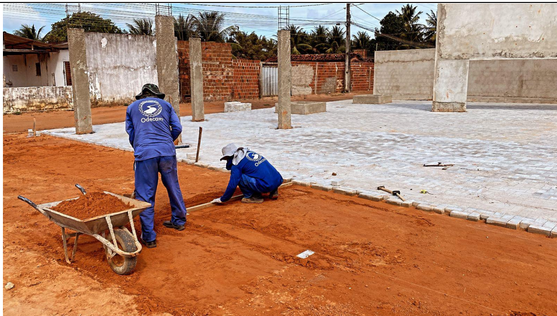
Figura 5. Instalação do piso intertravados de cor natural.
